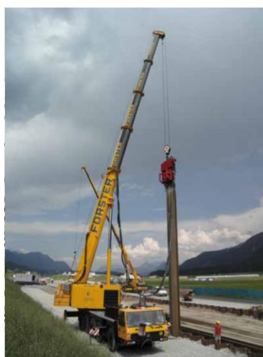
Beispielfoto: Baugerät treibt Spundwandbohle ein
